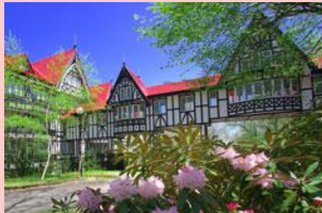
グリーンプラザ軽井沢外観
